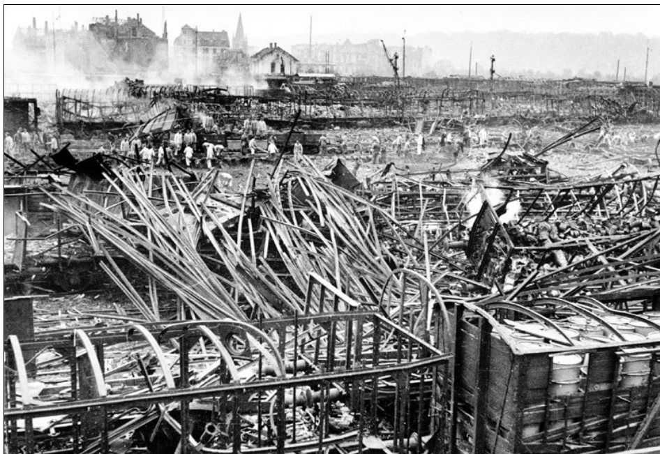
Trümmerfeld: Zerstörte Waggons und Gleisanlagen im Bereich des Rangierbahnhofs. Im Hintergrund ist der Kirchturm von Rothenbitmold zu sehen. QUELLE: STADTARCHIV
