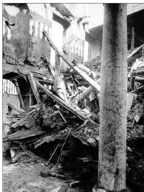
Zerstörtes Treppenhaus: So sah es im Fridericianum nach dem Bombentreffer aus. FOTO: STADTARCHIV
